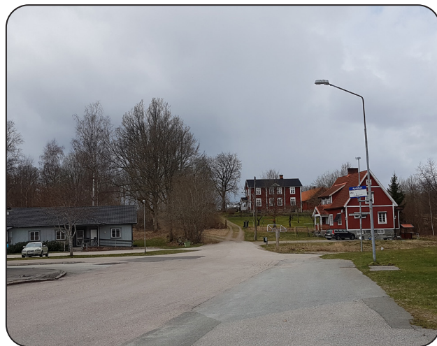
Bild 9. Befintliga bostadshus i närområdet
